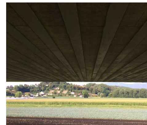
Renforcement par bandes en fibre de carbone
